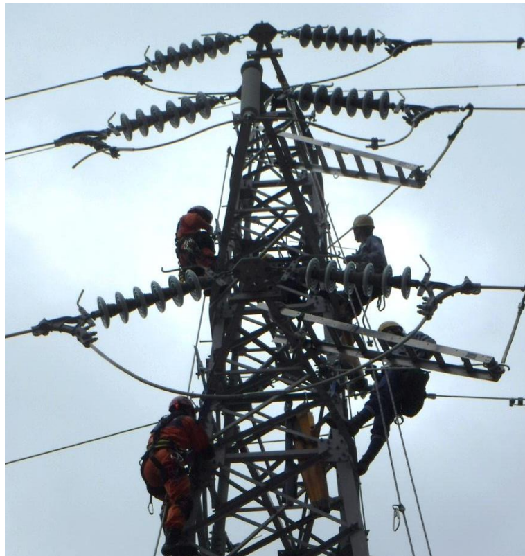
送電線付随装置で鉄塔を昇り、電線への乗り出し
